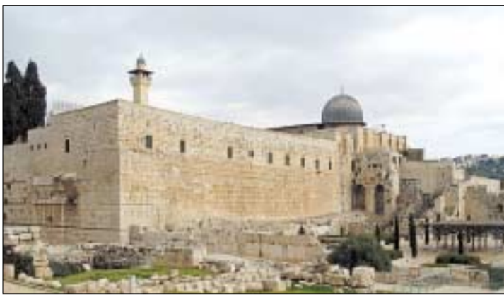
مطابق کاخ های اموی واقع در بخش جنوب شرقی حصارهای مسجد الاقصی بازدید کرده و از موارد متعدد هتک حرمت مسجد مبارک گروهی از «هیات مردمی بیت المقدس» از
